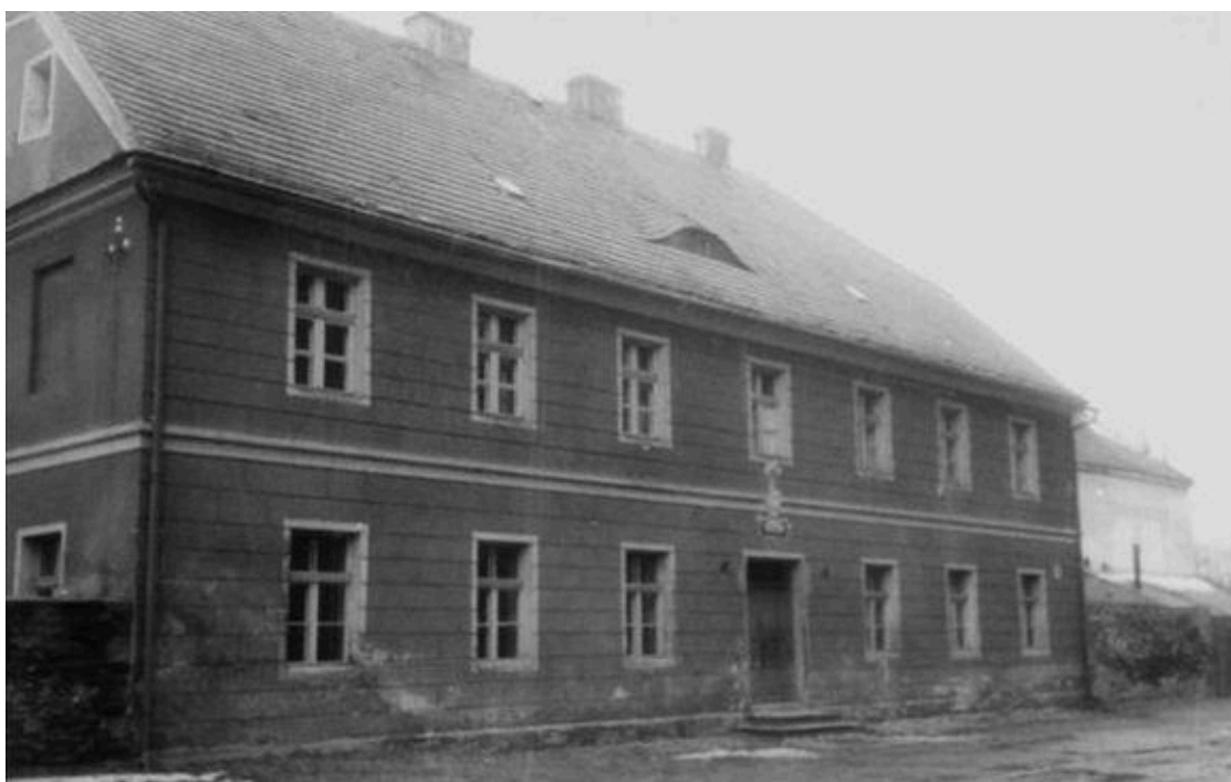
Widok na frontową (północną) stronę budynku szkolnego na Pl. Kościelnym 7.
